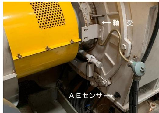
図8 AEセンサ取付け状況
