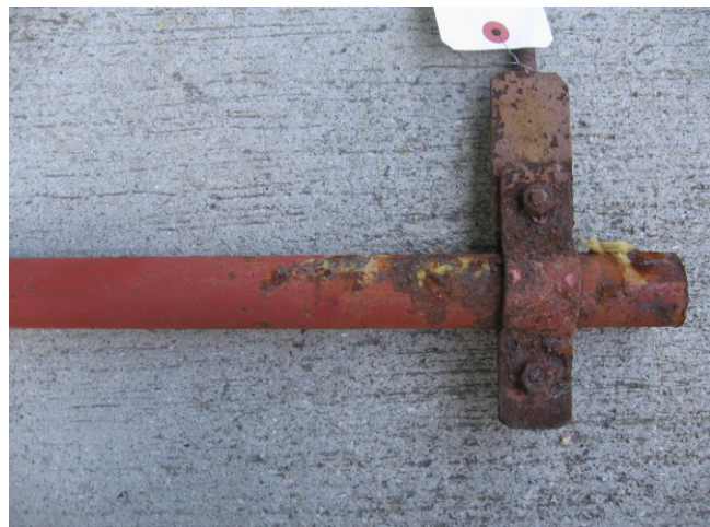
図6 計測対象配管の外観
